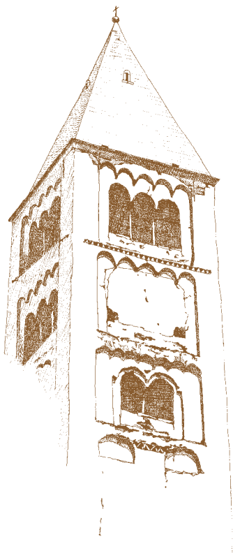
Il campanile della chiesa di Saint-Maurice prima del restauro
