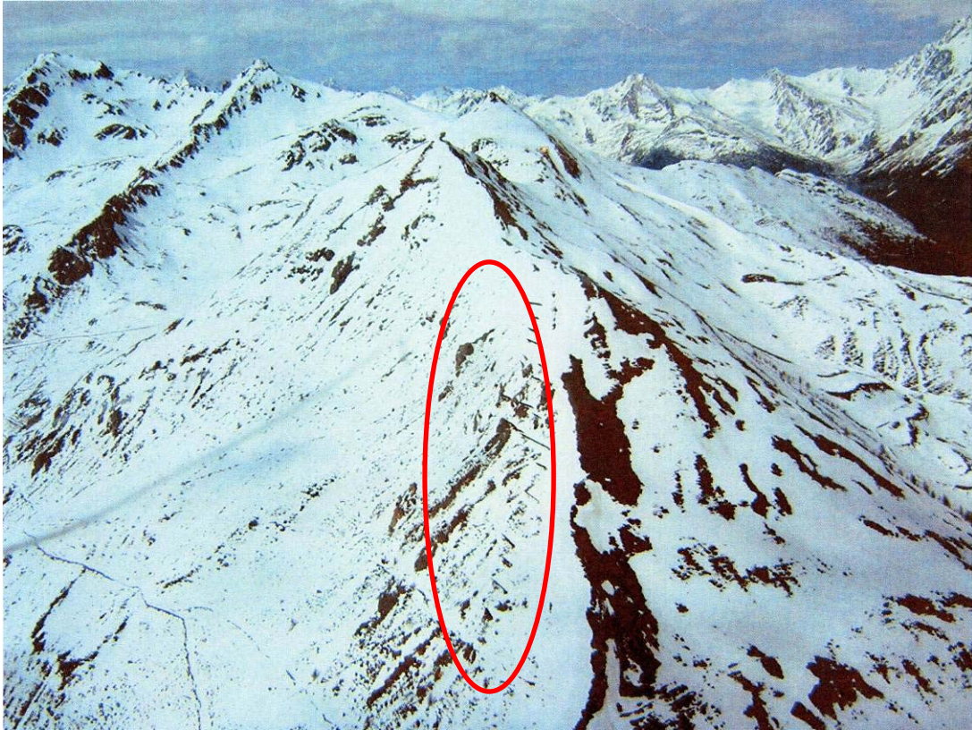
La punta Metz con il posizionamento dei ponti da neve realizzati.
