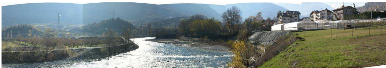
L'argine della Dora nel tratto prossimo all'Etoile du Nord.
